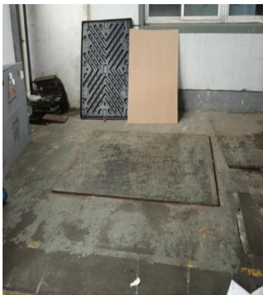
图4 地下事故应急池
